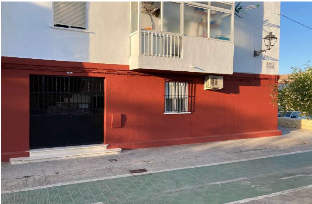
Calle Guadalquivir, Bloque 2, Utrera (Sevilla)
