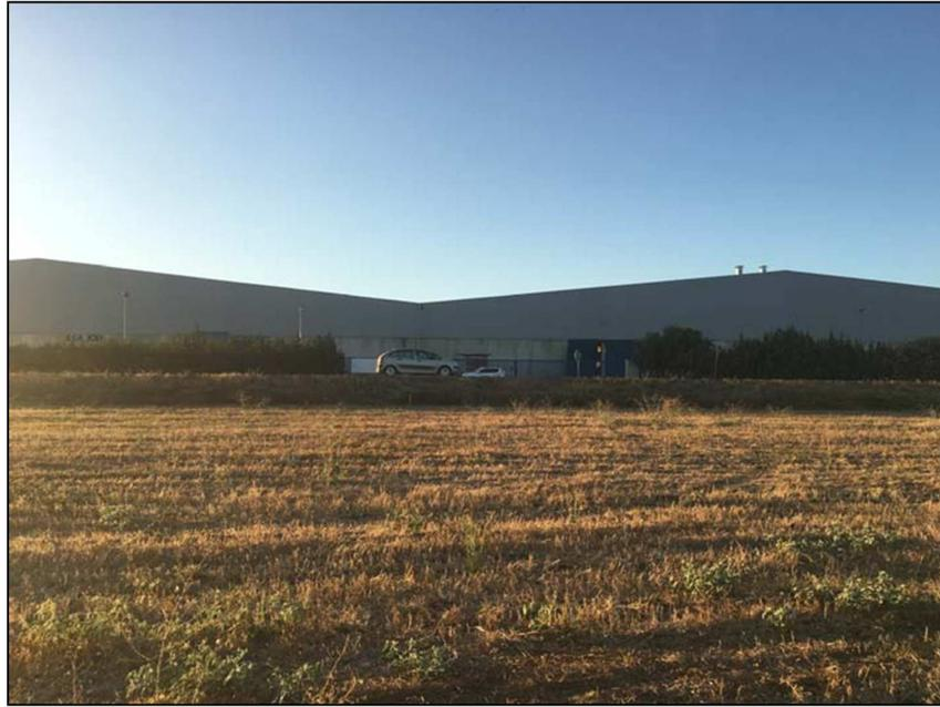
Imagen nº 7. Vista de las naves objeto de modificación del proyecto de actuación. Observese desnivel existente entre los terrenos inundables y la plataforma de la carretera, cercano a los 2 metros en esta zona.
