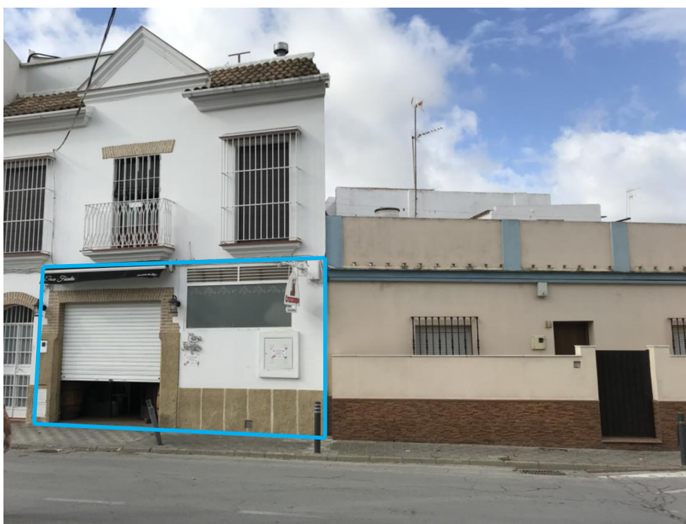
Fachada exterior del local y su colindante por la derecha
