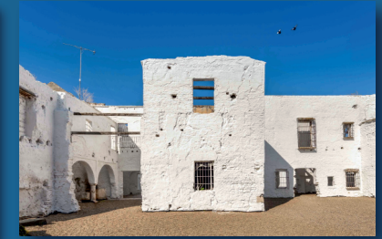
Estructuras existentes hacia el patio trasero
