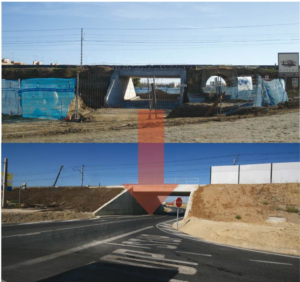
PUENTE DE LAS ALCANTARILLAS
