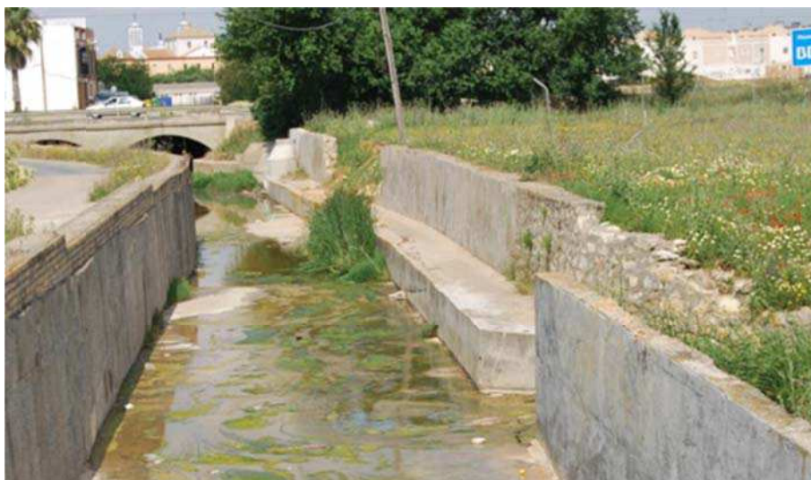
Arroyo Calzas Anchas (trazado Original). Encauzamiento.
