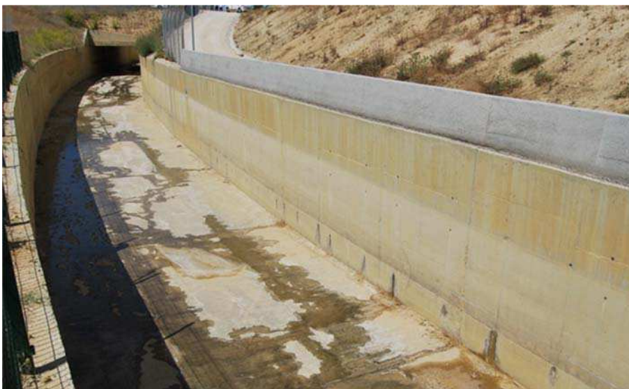
Arroyo Calzas Anchas (Encauzamiento).
