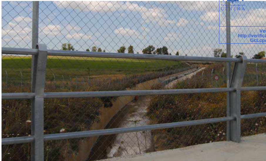
Arroyo Calzas Anchas (Encauzamiento).
