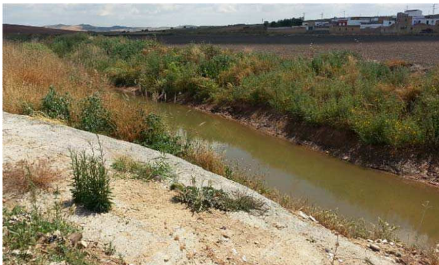
Arroyo Innominado 8 (Cauce natural).
