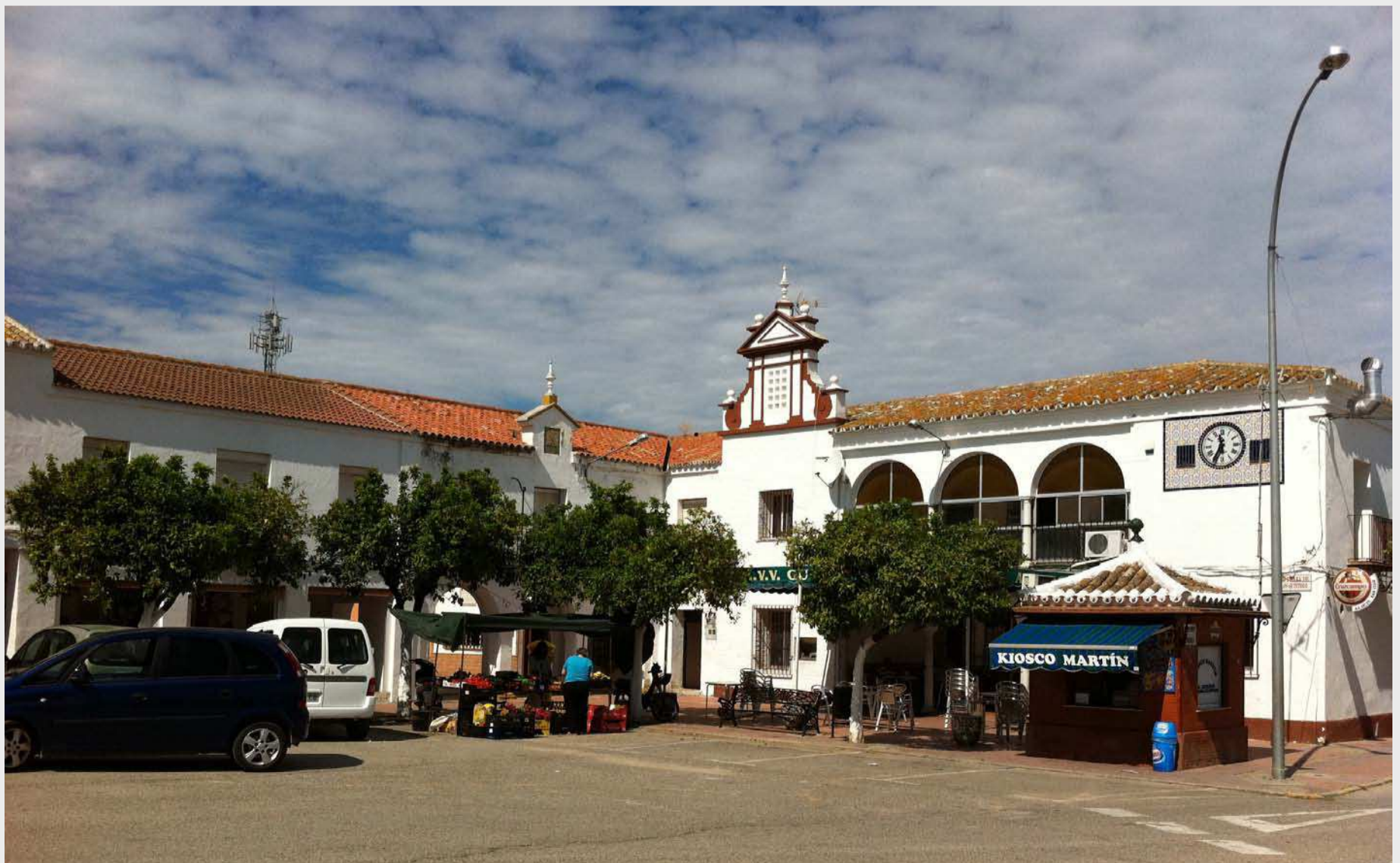
Plaza Mayor del pueblo de colonización de Guadalema de los Quintero.
