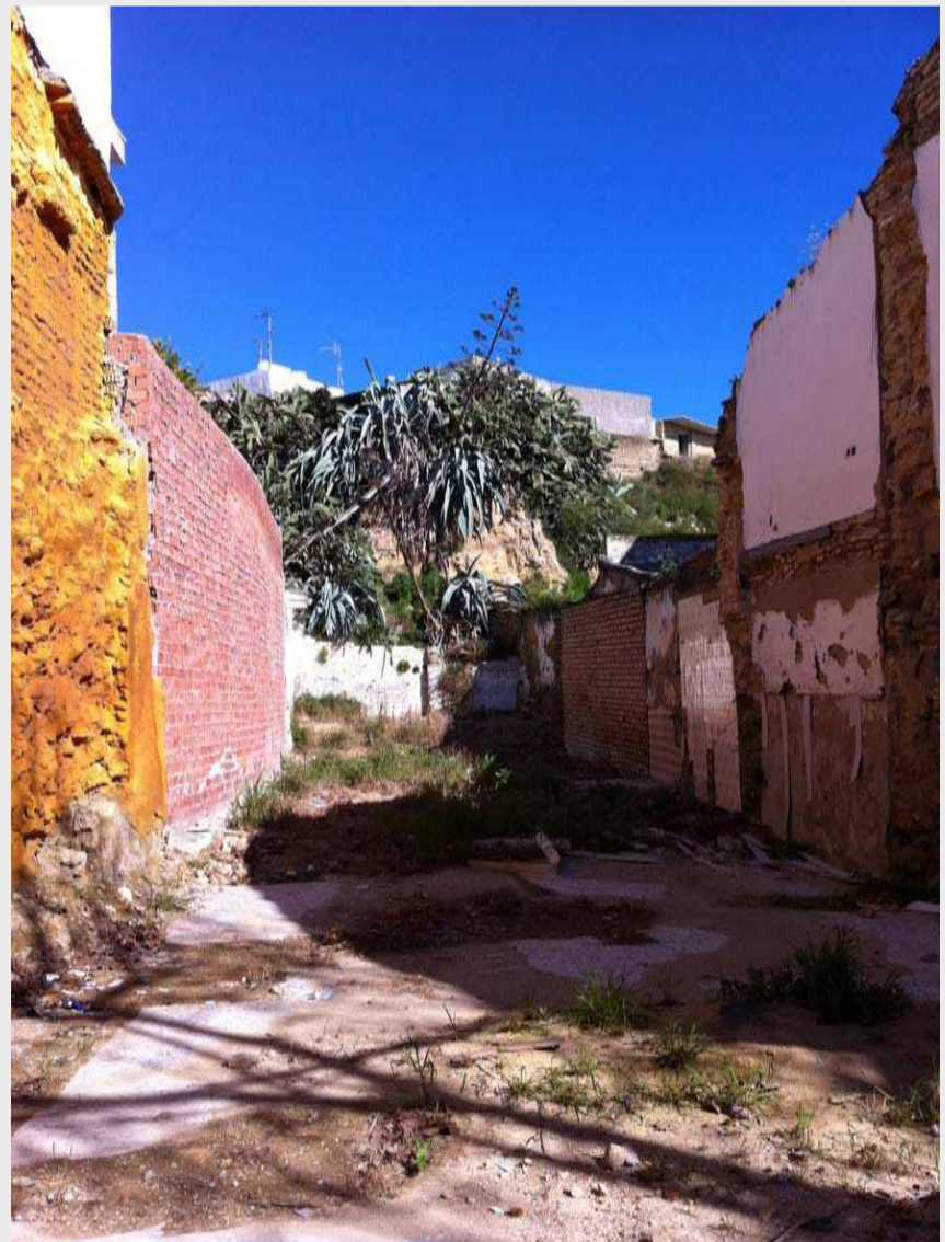
Restos del lienzo de la muralla desde la calle Cristo de los Afligidos, Utrera.
