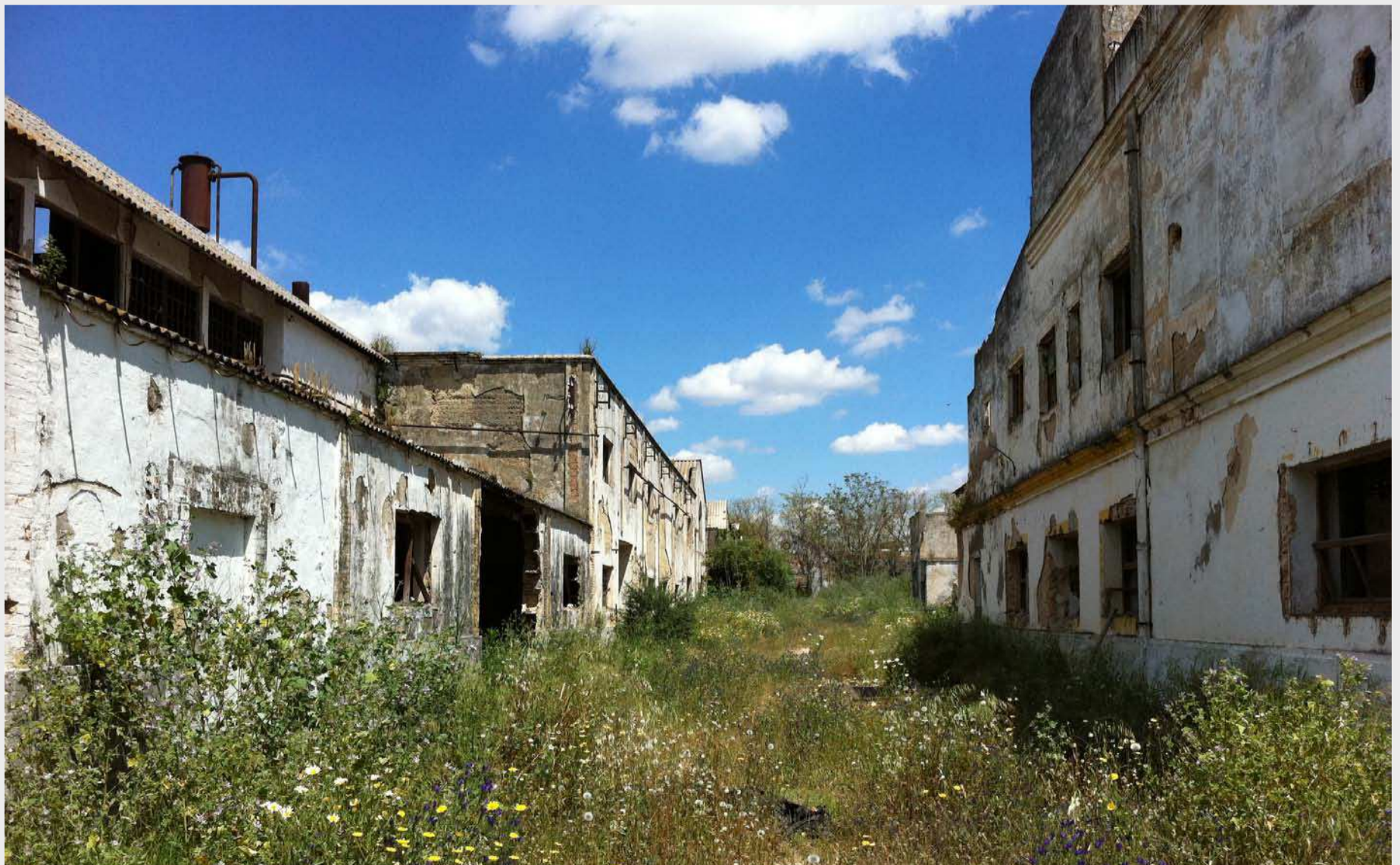
Calle interior de la fábrica de la Fontanilla, Utrera.
