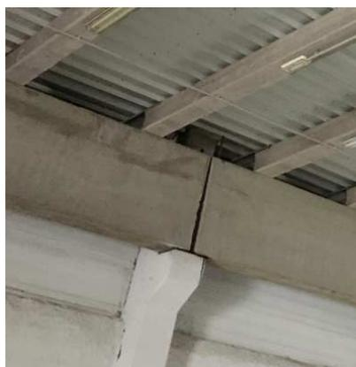
La cubierta es transitable e inclinada a un agua y resuelta mediante chapa sándwich apoyada sobre correas de hormigón, según foto adjunta.
