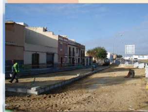
Canalización en Los Puertos
